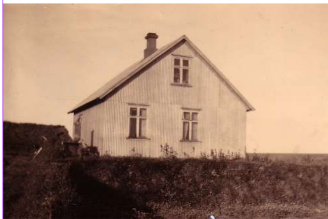
Íbúðarhúsið á Hurðarbaki, séð aftan frá. Myndin er sennilega tekin fyrir 1940, áður en vindmylla var sett á þakið.
